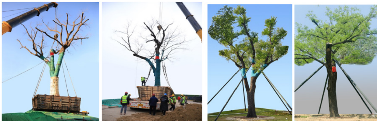
A - 780 井字形工字钢托架吊运
